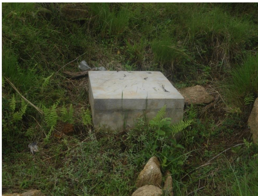
Figure 13. OUVRAGE DE CAPTAGE DE LA SOURCE
