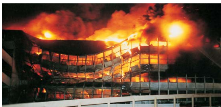
Feu dans un collège d'enseignement secondaire (construction légère à ossature en acier), Colombes, 1992.
