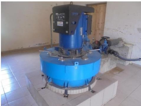
Photo 28 : Turbine de conversion de la force hydraulique en électricité
