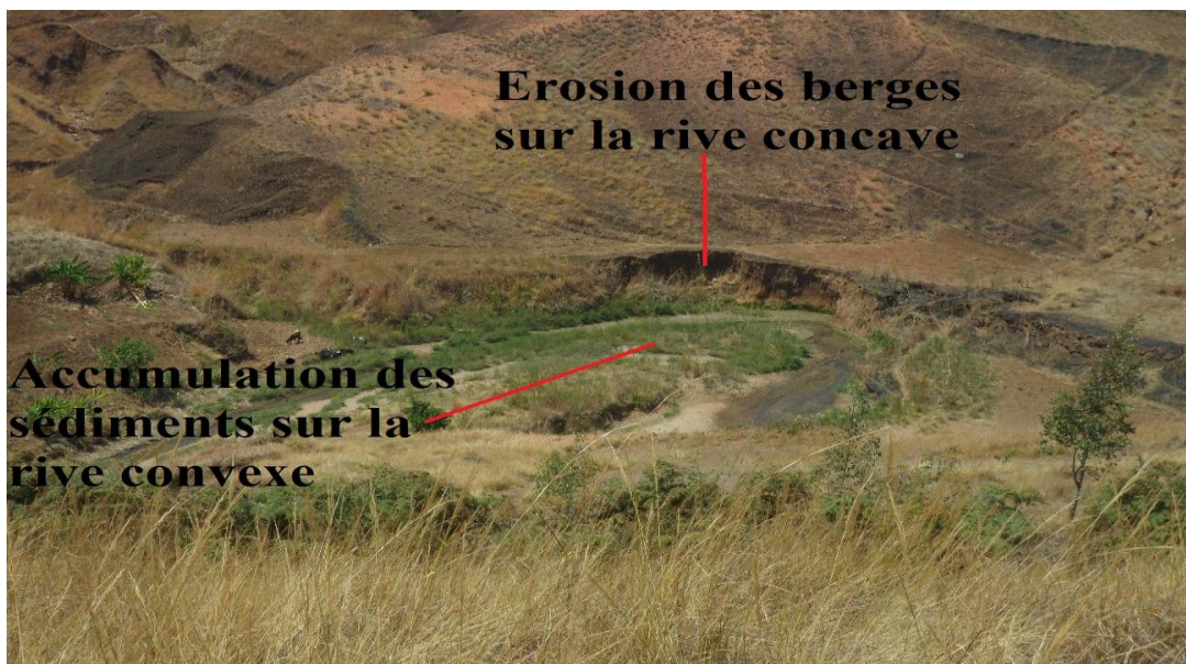
Photo 16. Des lits à méandres sur la rivière Andranomena Nord
