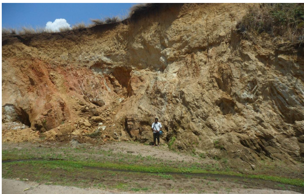
Photo 13 Un exemple de glissement de terrain sur la rive droite de la rivière Andranomena Nord
