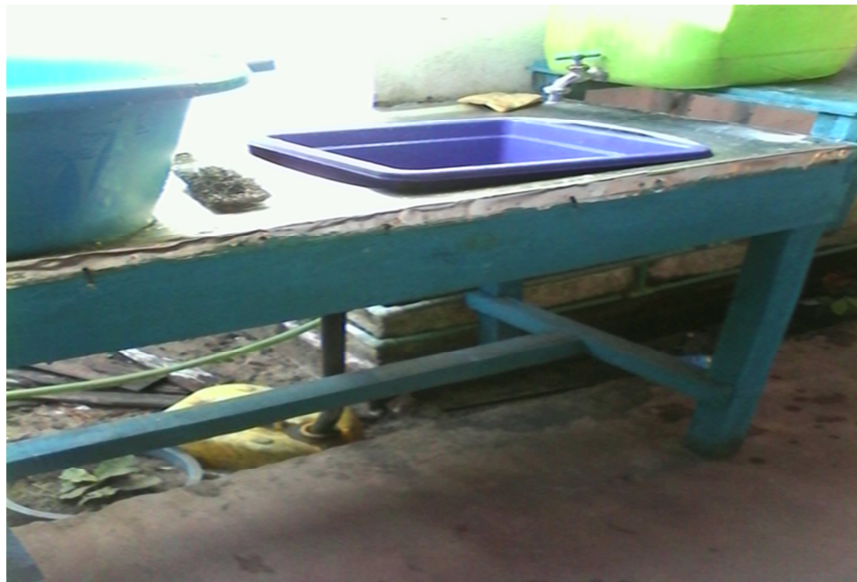
Figure 8 : Rejet des eaux domestiques
