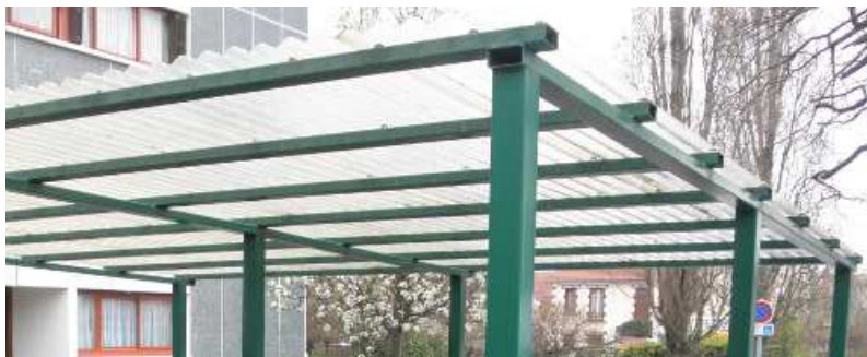
Figure X.1 – Charpente constituée d'un assemblage de poutres
