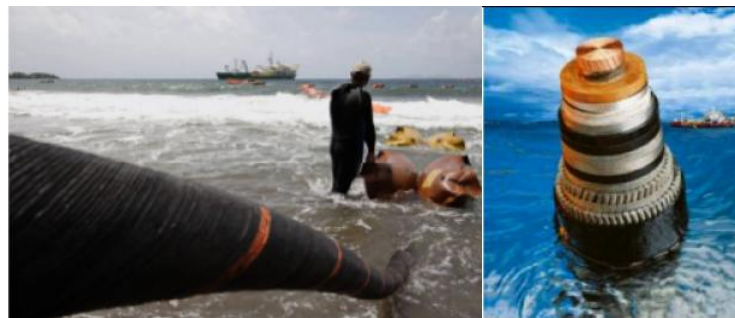
Pose du câble CCHT
