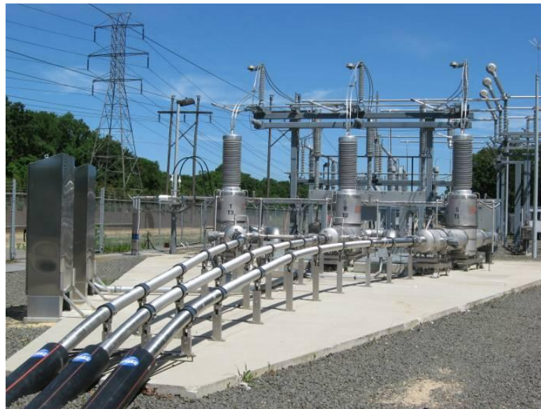
LIPA : premier câble supraconducteur haute tension au monde
