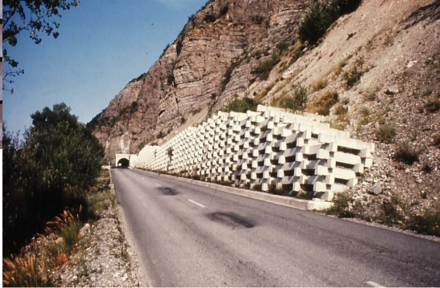
Murs constitués d'éléments préfabriqués
