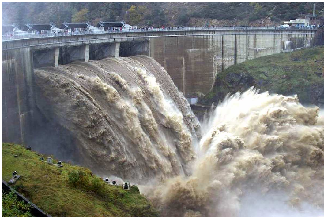
Figure 5.41 : crue de la Loire de novembre 2008 et passage de la crue au niveau de l'évacuateur de crue du barrage de Grangent. Source: DIREN.
