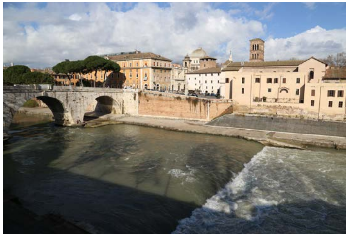
Figure 5.51 : seuil dénuyé sur le Tibre au niveau de l'Île tibérine à Rome.
