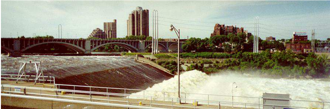
Figure 5.42 : ressaut hydraulique stationnaire sur le Mississippi au pied du seuil du Saint-Falls Laboratory de Minneapolis (États-Unis). Source : www.thefullwiki.org/Hydraulic_jump .
