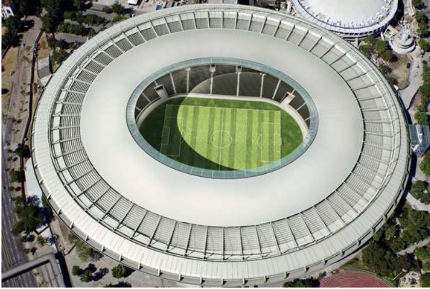
Figure 1.15 : pour le projet de réhabilitation du stade Maracanã de Rio de Janeiro pour le Mondial de football et les Jeux Olympiques, les concepteurs ont prévu de couvrir les gradins à l'aide d'une enveloppe comportant un film plastique couvert de téflon pour éviter l'imprégnation (qui serait préjudiciable au poids que doivent supporter les poutres de la structures) et faciliter le drainage (dans un climat subtropical, les pluies peuvent être très intenses). Source: http://placar.abril.com.br .
