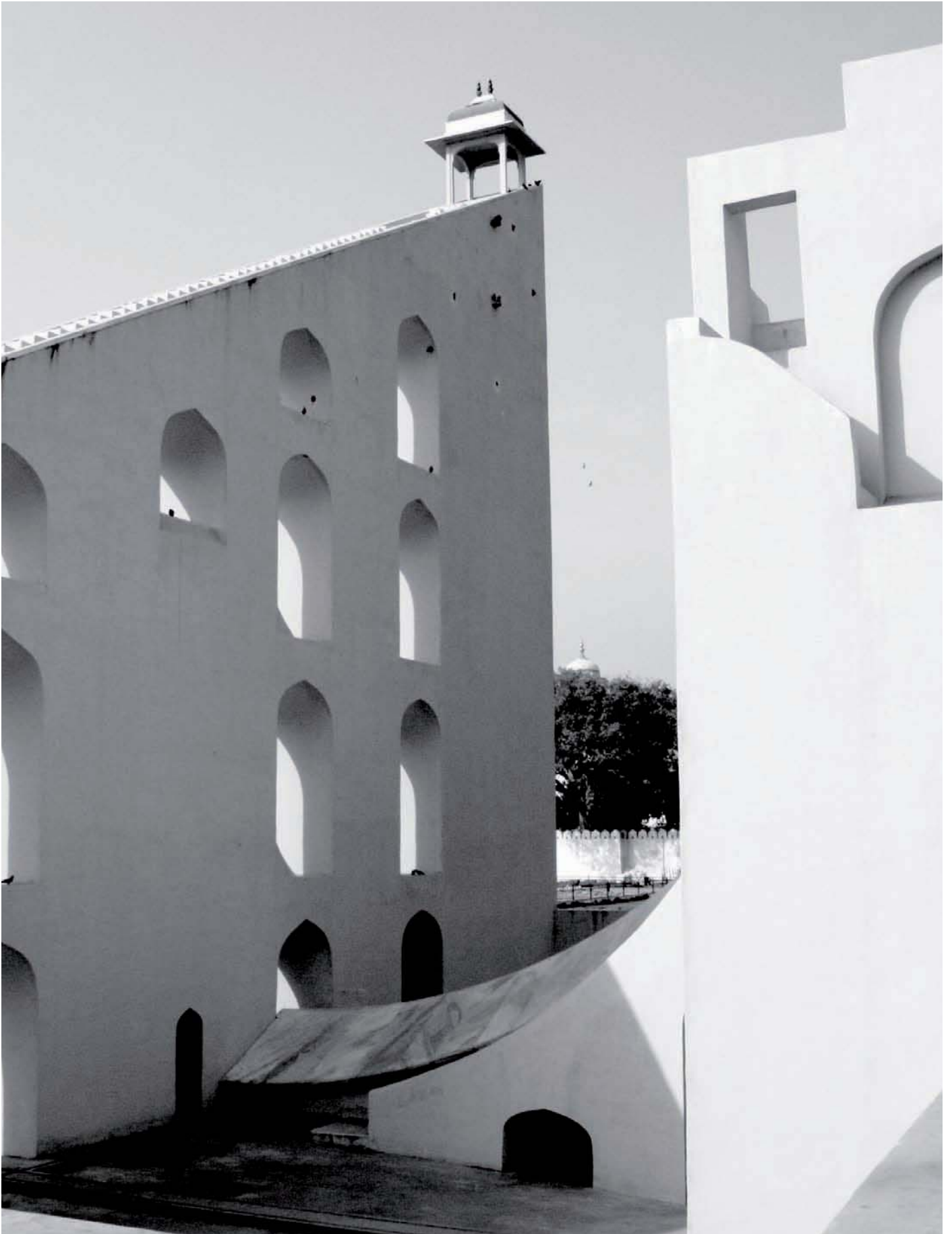
Observatoire de Jaipur, XVIII e siècle © A. ClementeRuiz À Jaipur au XVIII e siècle, un observatoire a été construit à côté du palais afin de permettre aux scientifiques de réaliser des calculs d'une grande précision grâce au gigantisme des outils utilisés.
