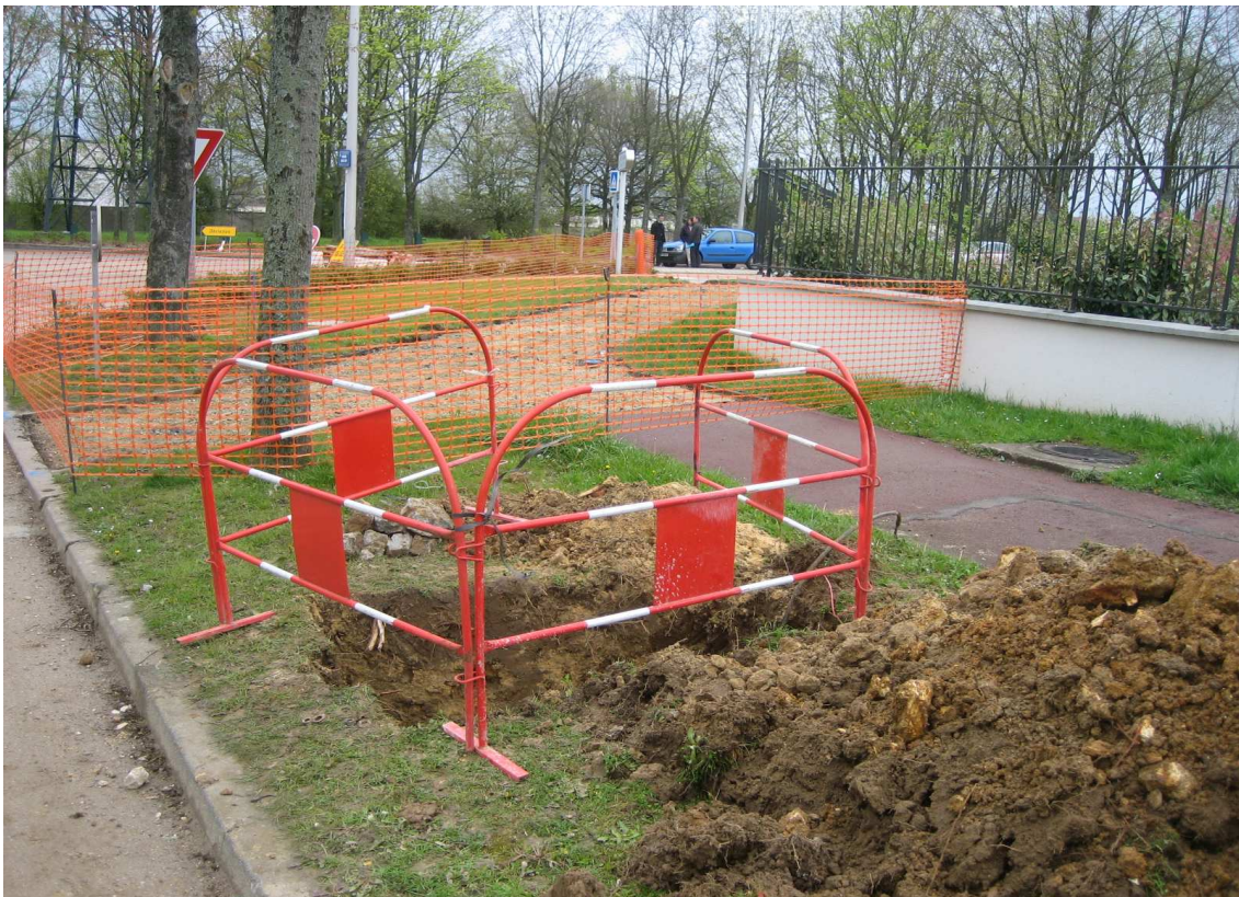
Site de travaux de rénovation Elancourt 78 (source personnelle)
