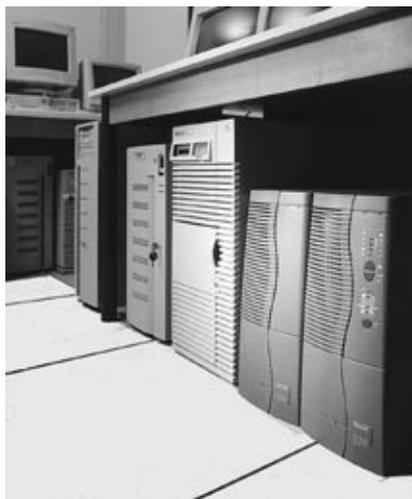
**Fig. N30b** : Onduleur réalisant la disponibilité et la qualité de l'énergie qui alimente des ordinateurs
