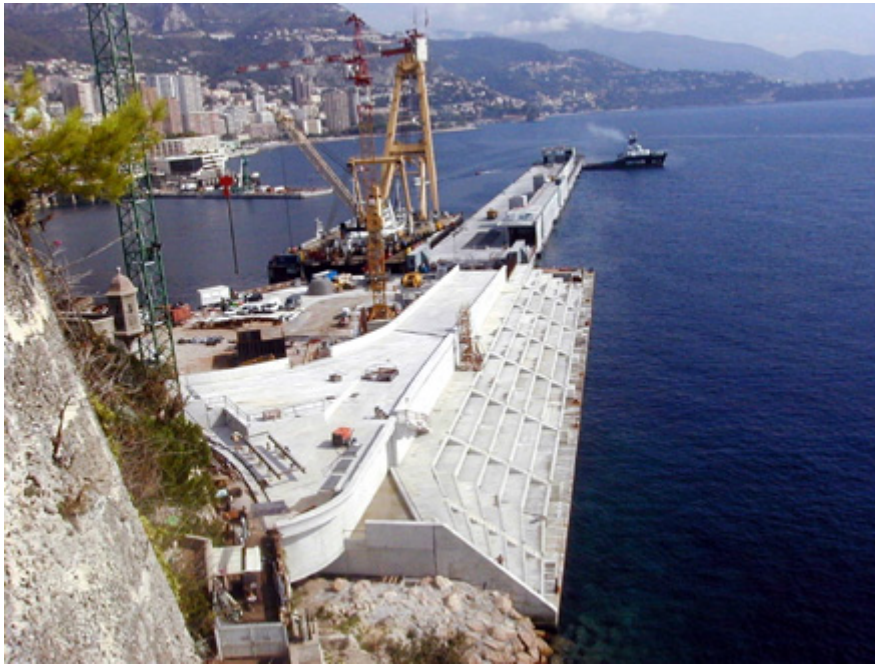
Un ouvrage innovant au port de Monaco
