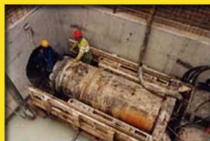
Microtunnelier en preparation
