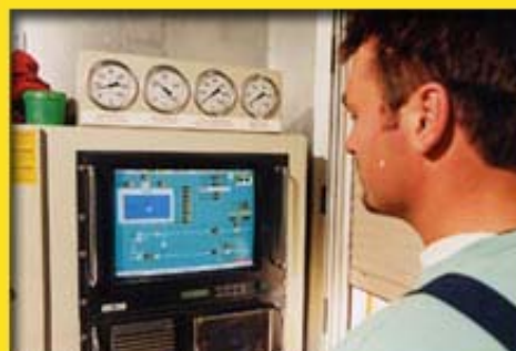
Le pilote dirige le microtunnelier
