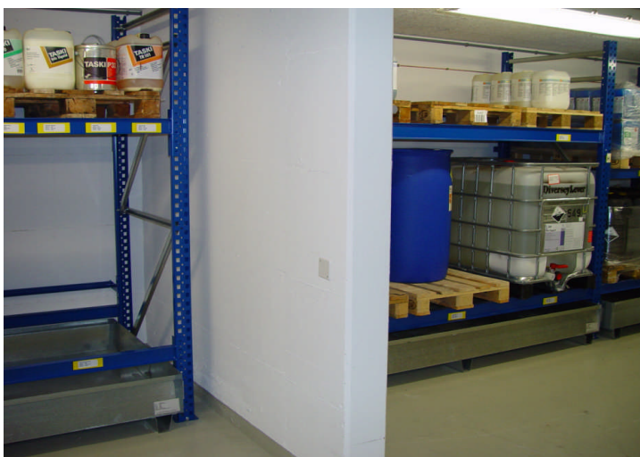
Stockage séparé (paroi de séparation et bacs de rétention séparés) dans le même compartiment coupe-feu
