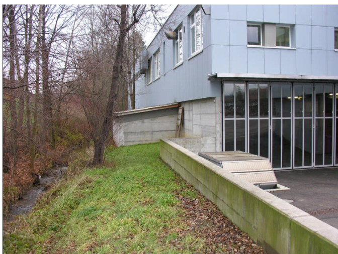
Protection d'un entrepôt de produits chimiques contre les crues
