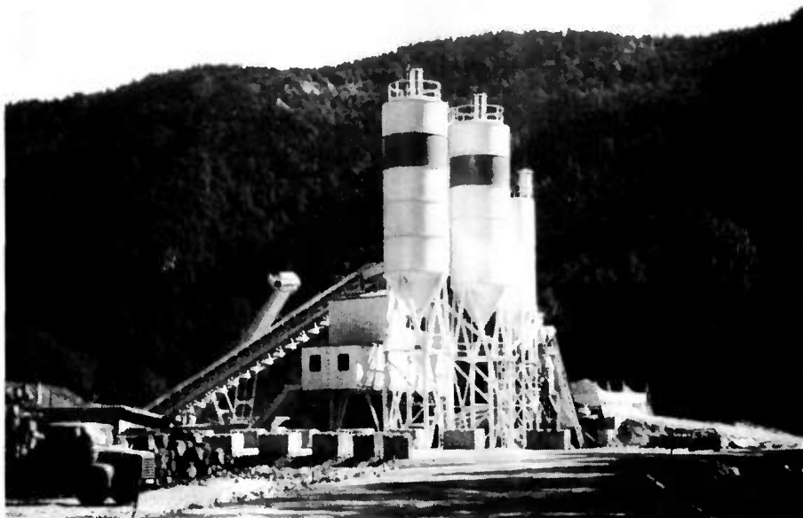
Figure 18. Autoroute A.40. Tunnel de Chamoise. Centrale de fabrication du béton tête Neyrolles.
