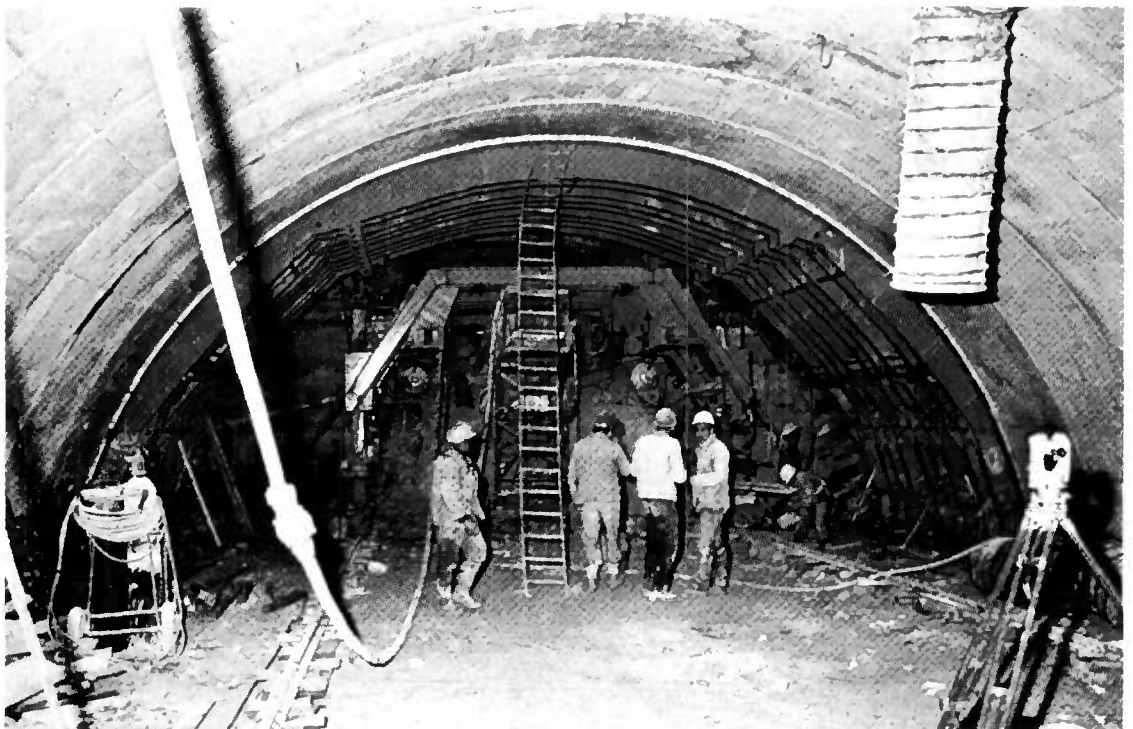
Figure n° 2. Autoroute A 13 - Tunnel de St-Cloud. Bétonnage à l'avancement en demi-section supérieure.
