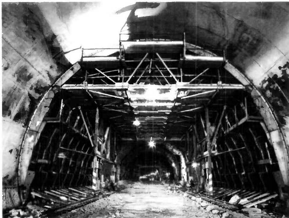
Figure 21. Autoroute A. 8. - Tunnel du Col de l'Arme.
