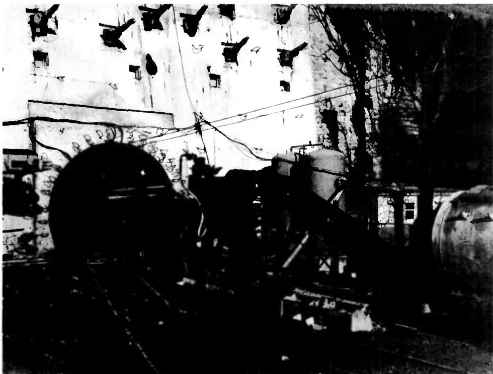
Figure 36. Galerie technique sous Fourvière - Lyon. Train pour injection de remplissage.
