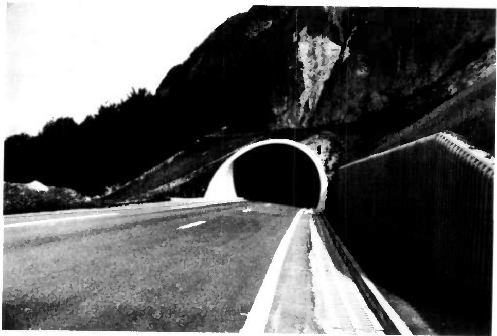
Figure 28. Autoroute A. 40 - Tunnel de Vuache, tube Nord - Tête Ouest.
