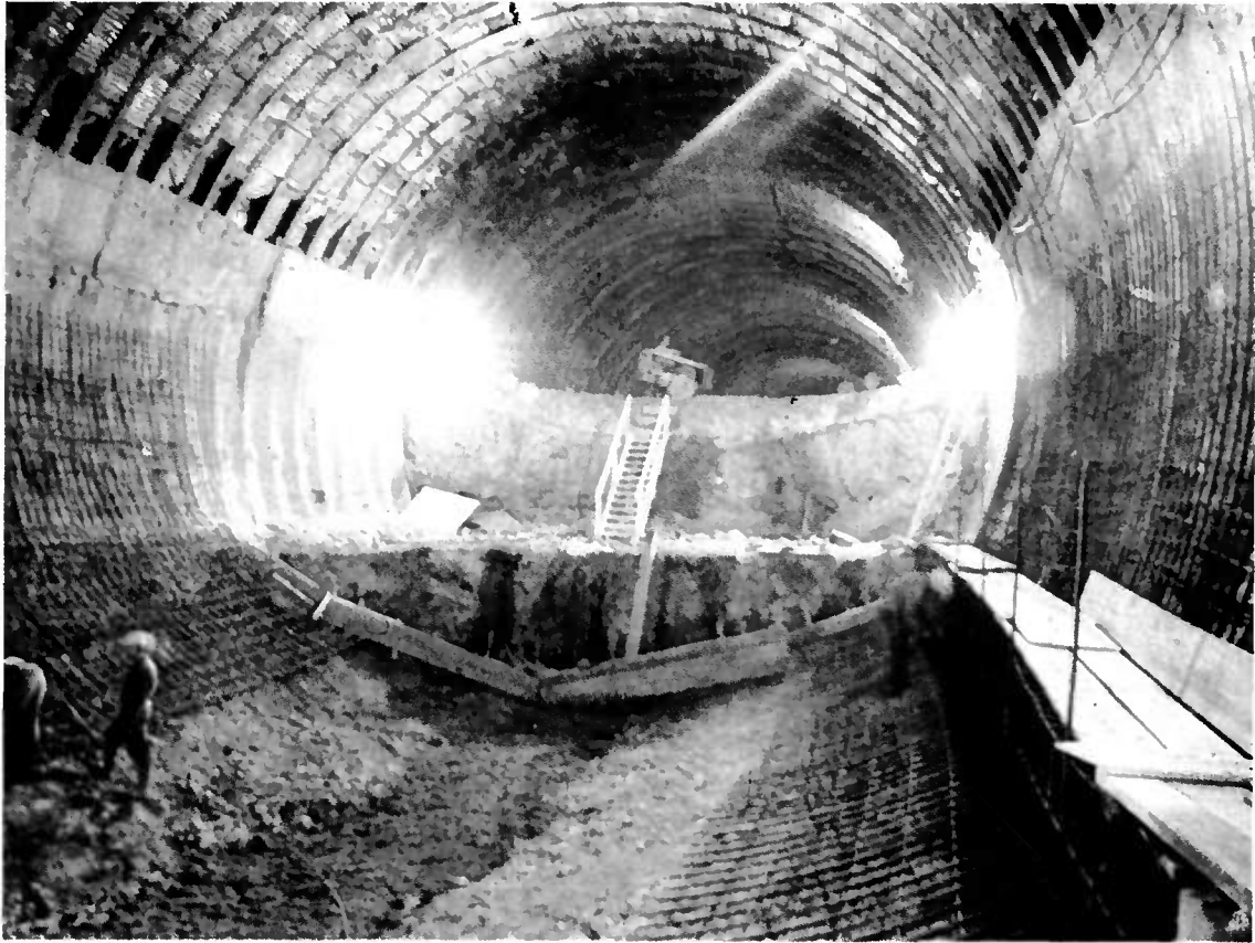
Figure n° 5. Autoroute A 8 - Tunnel du Col de Guerre. Ferrailage en cours de la contre-voûte et des pénédroits
