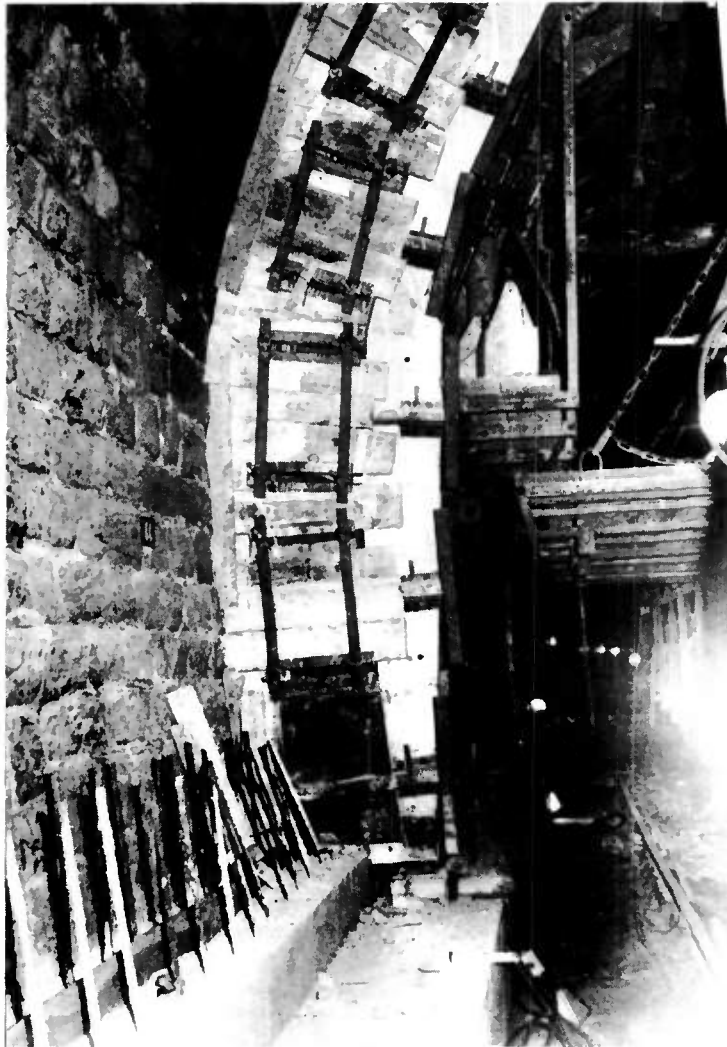
Figure 25. Tunnel de Buswiller - SNCF - Coffrages d'arrêt ou masque.
