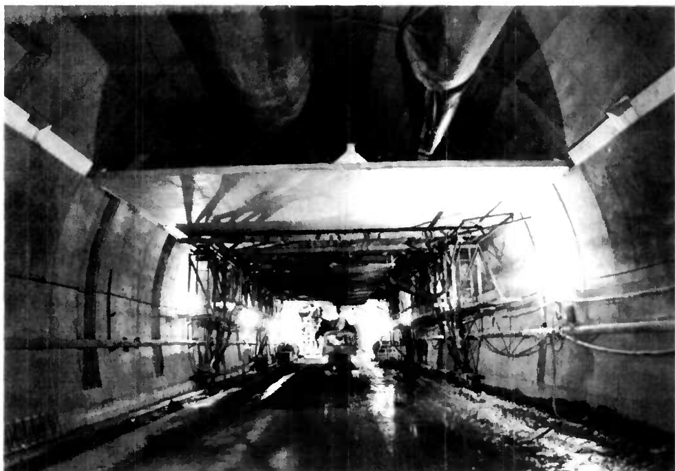
Figure 15. Tunnel routier du Fréjus. Bétonnage de la dalle des gaines de ventilation.
