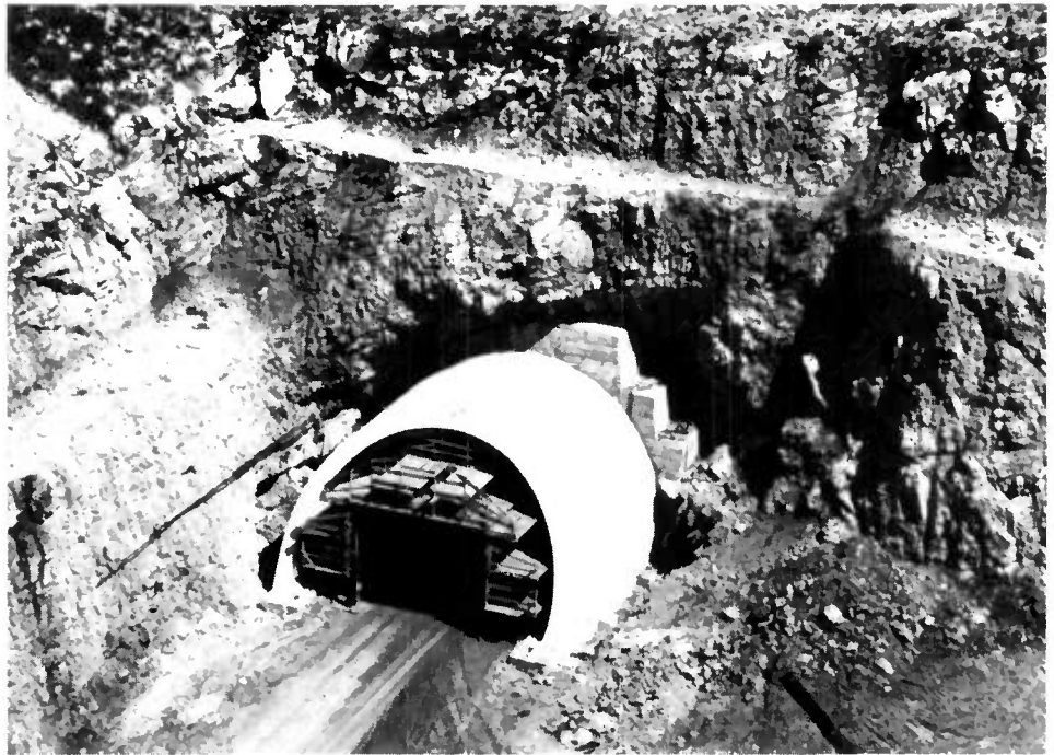
Figure 13. Autoroute A 8 - Tunnel du Col de Guerre - Tête ouest.
