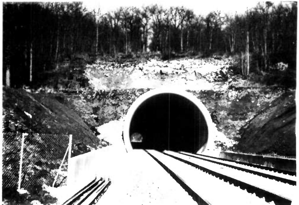
Figure n° 9. SNCF - Ligne Paris-Mulhouse. Tunnel de Marnay
