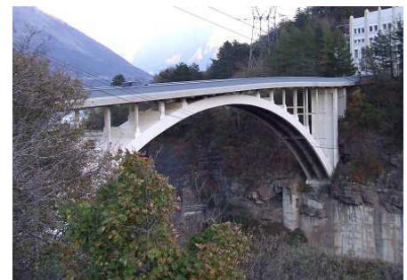
Pont du Sautet (Sud de Grenoble). Albert Caquot, 1928
