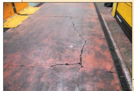
Fig. 3 - Ouverture importante des fissures de retrait.
