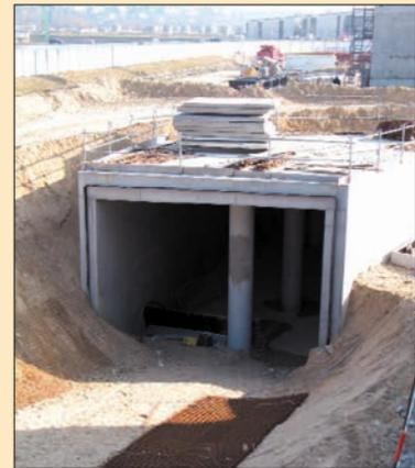
La lixiviation touche souvent les ouvrages hydrauliques. Construction d'une conduite d'amenée des eaux usées dans une station d'épuration.
