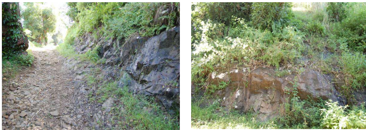
Figure 4 : Chaussée sur un banc rocheux (PK42+100)
