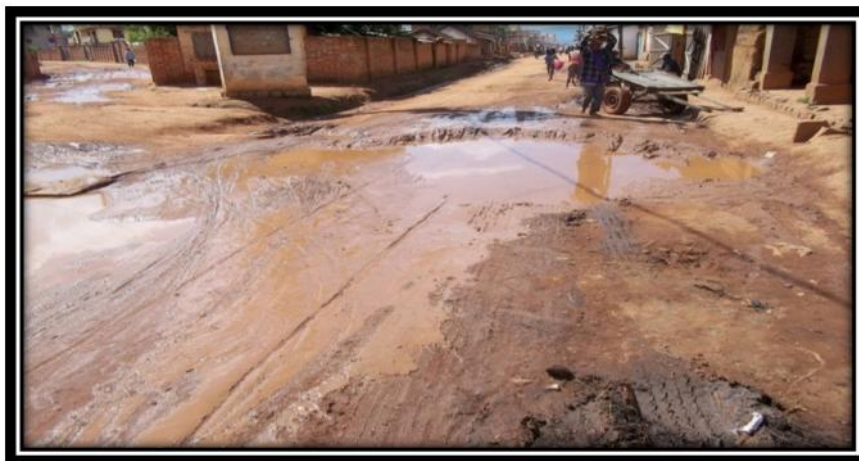
Photo 1: Stagnation des eaux de pluie dans les quartiers
