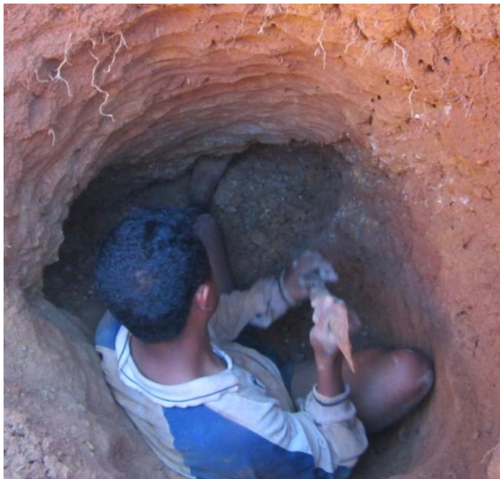
Figure 3 : Le puit de récupération
