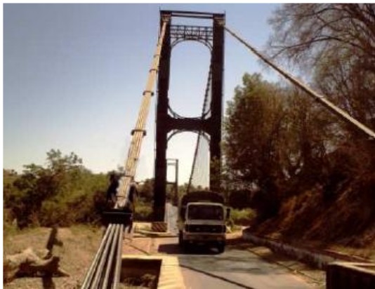
Photo 2 : Pylône coté Majunga - câble porteur et suspentes
