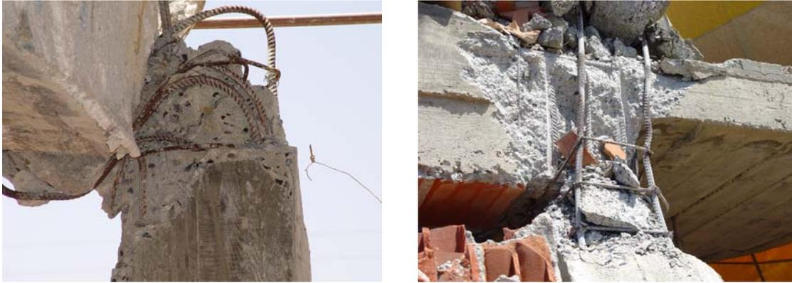
Figure 10.23. Effondrement dû à l'absence d'armature transversale au nœud.
