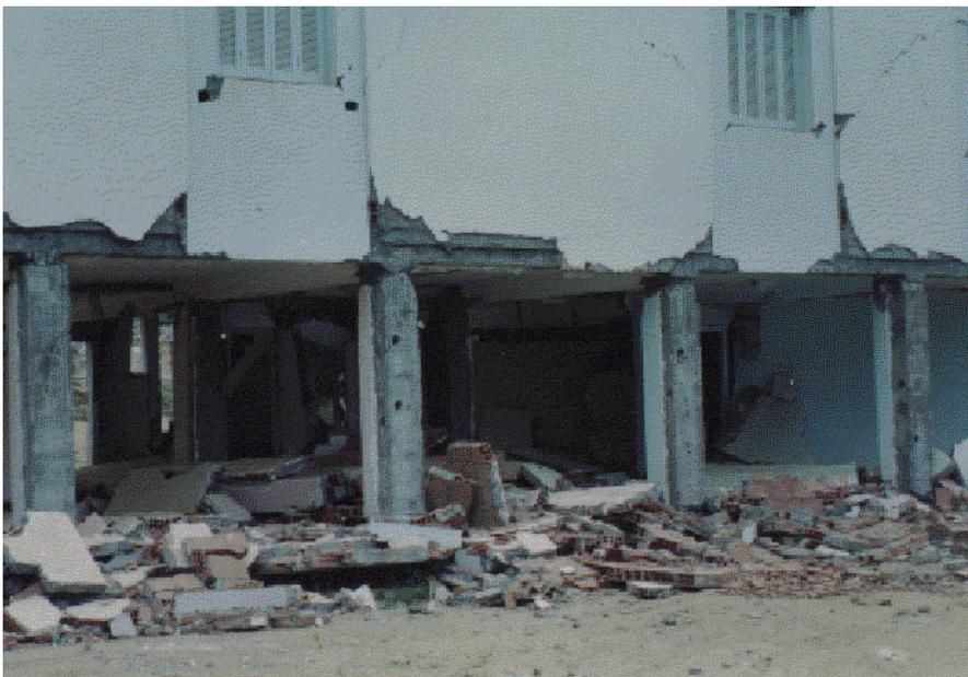
Figure 10.37. La ruine des murs de remplissage du rez-de-chaussée induit une irrégularité en élévation.
