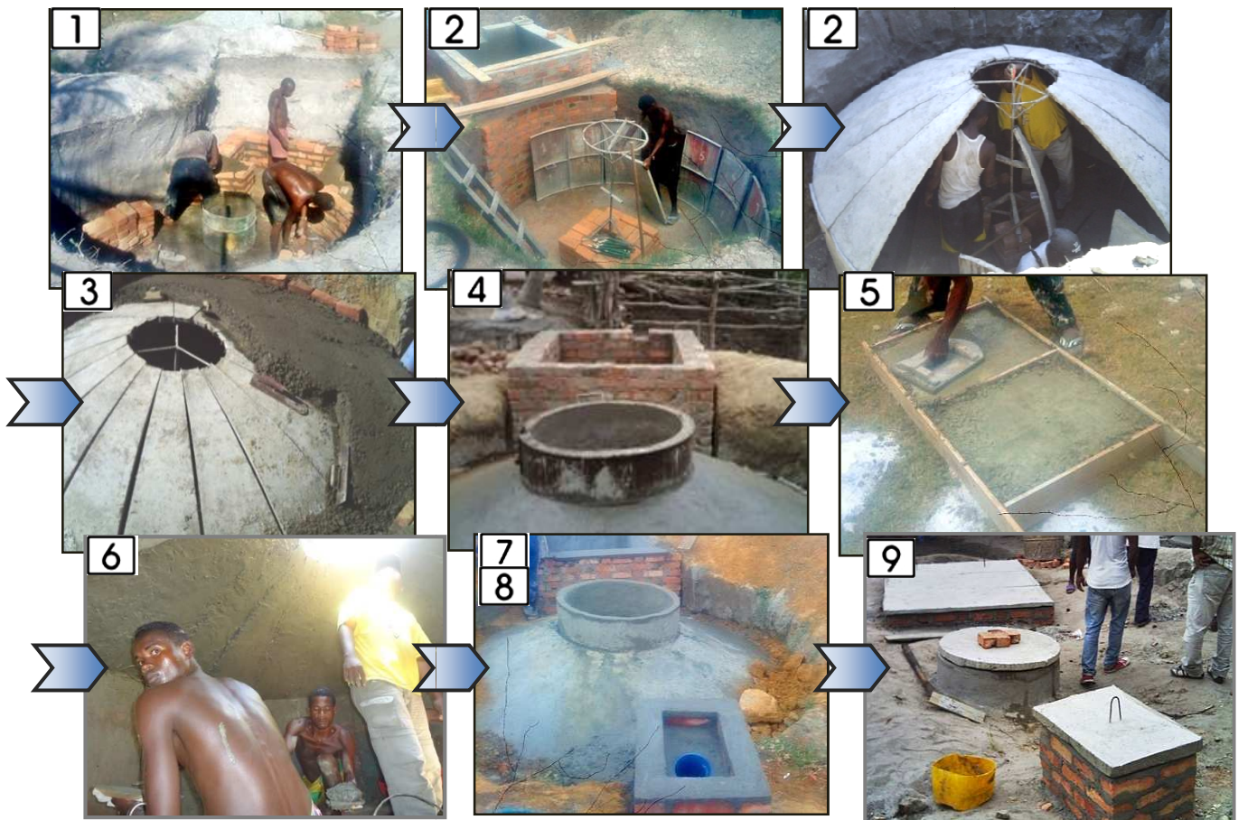
Photo n° 5 : Déroulement des travaux de construction
