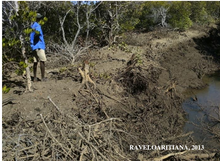
Photo 6 : Erosion des rives de chenal de mangrove à Ampampamena
