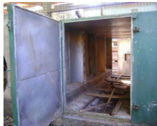
Figure 48: Chambre de séchage
