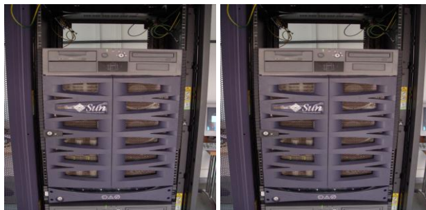
Salle des serveurs
