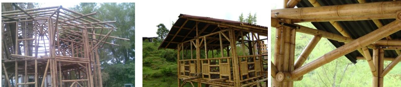
**Photo 4 : Bambou géant utilisé en tant que matériaux de construction après traitement chimique uniquement.**
