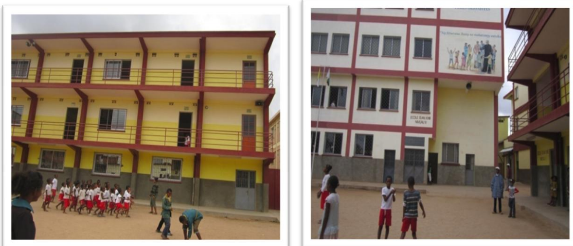
Photo n° 3: Les bâtiments scolaires du Collège Jean XXIII Anatihazo isotry
