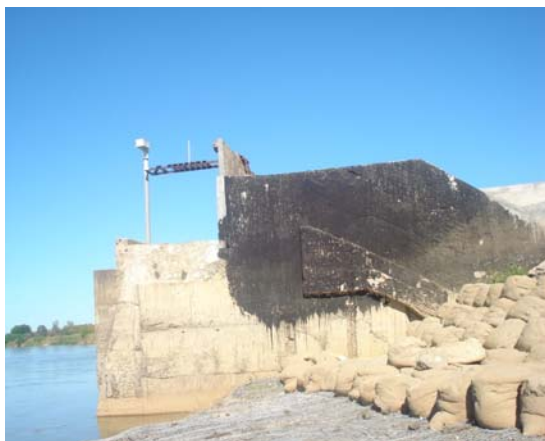
Photo n°3 : Protection provisoire en enrochement en aval de la prise
