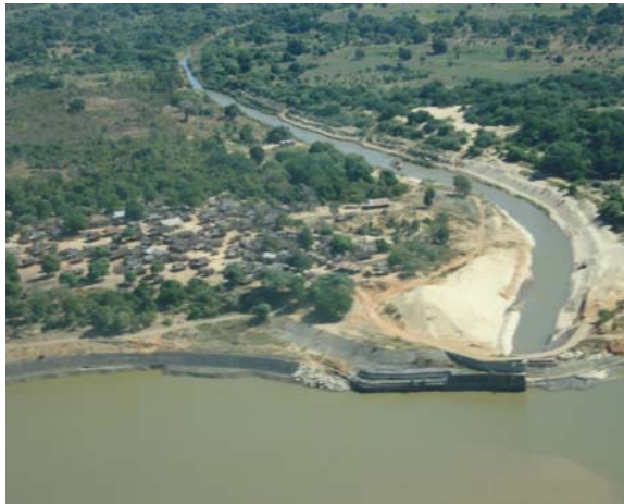
Photo n°5 : Vue aérienne de l'ancienne prise d'eau
