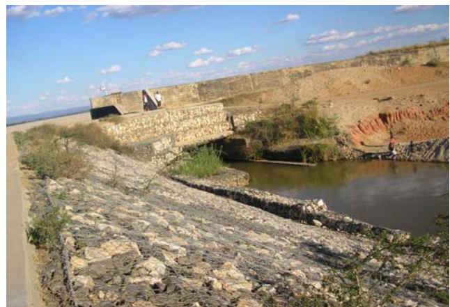
Photo n°4 : Protection de l'avant canal par un matelas de gabions
