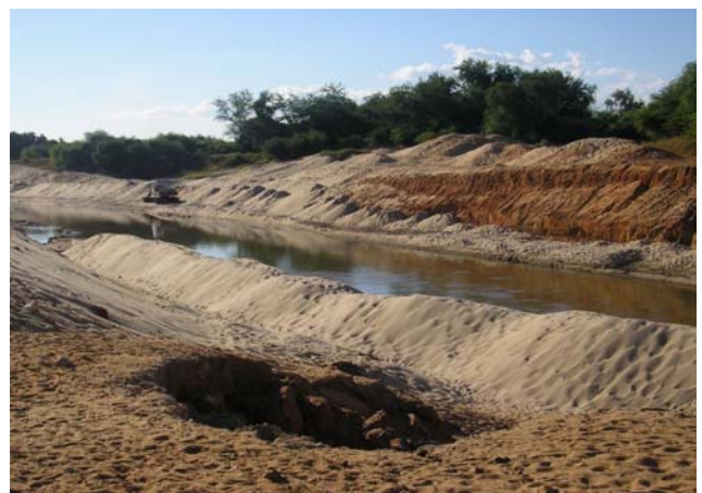
Photo n°2 : Ensablement de l'avant-canal
