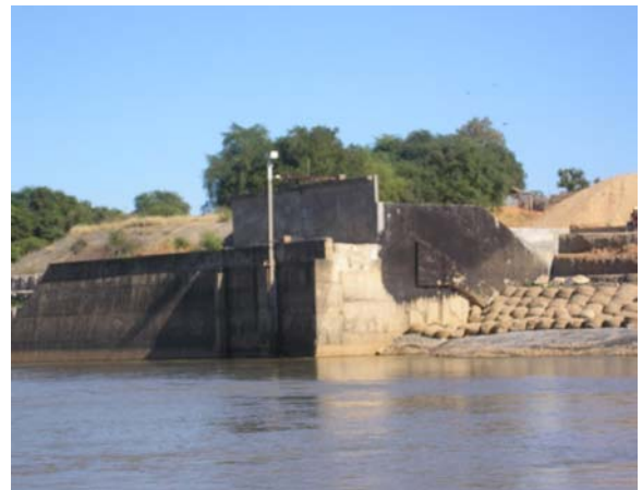
Photo n°8 : Paroi verticale de la prise d'eau
