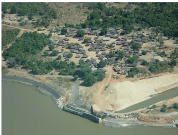
Photo n°1 : Erosion de la berge amont (vue aérienne)
