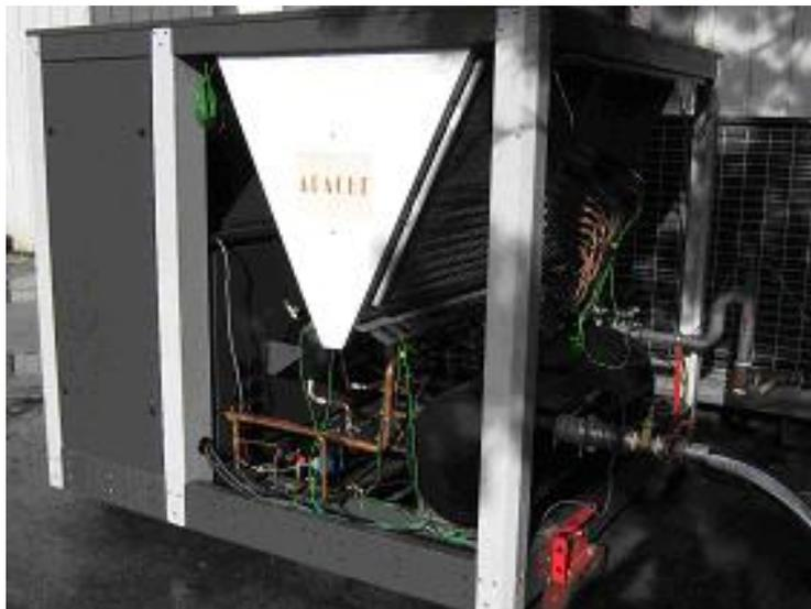
Figure 3-19 : Photo du prototype
