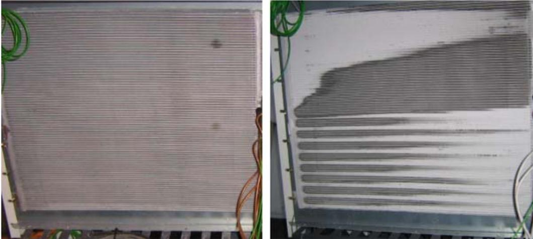
Figure 3-4 : Givre sur une batterie à air (à gauche batterie sèche, à droite batterie givrée)
