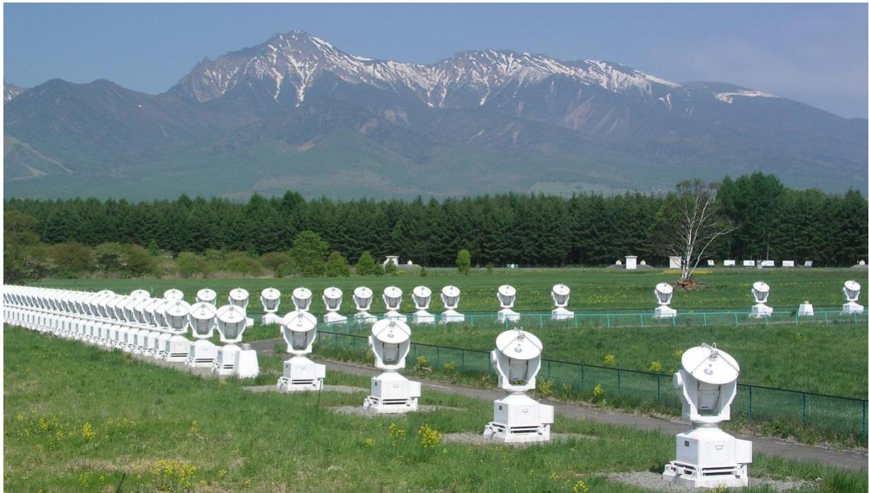
*Radiotélescope de Nobeyama composé d'une centaine d'antennes alignées sur deux directions (©NAOJ). L'instrument a un pouvoir séparateur proche d'un télescope unique dont la taille serait voisine de l'alignement.*
