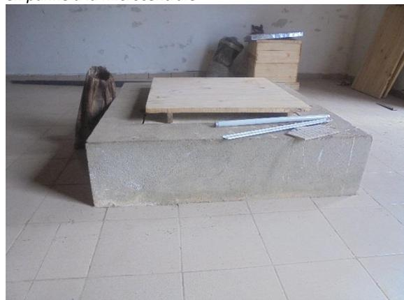
Photo 61 : Support en béton de la deuxième turbine
