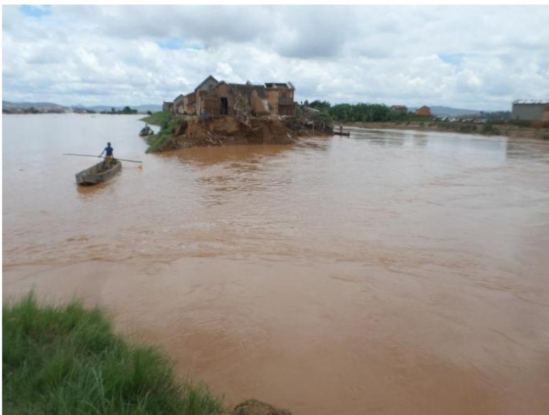
Figure 43: Rupture de la digue vue de l'aval de la digue de sisaony à Vahilava, Soavina
