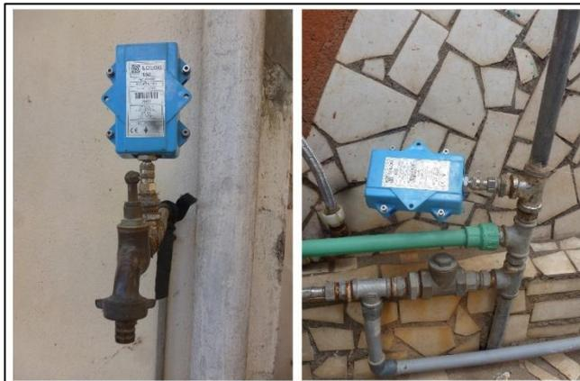
Figure 28: Manomètres installés
