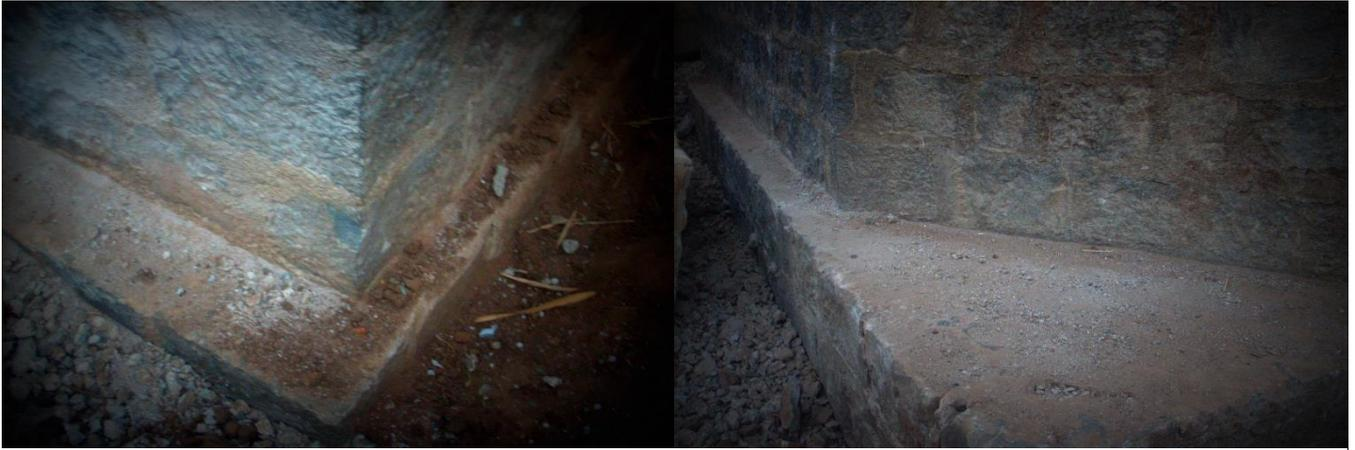
**Figure 63 :** Fouille de la fondation de l'ancienne pile en maçonnerie
