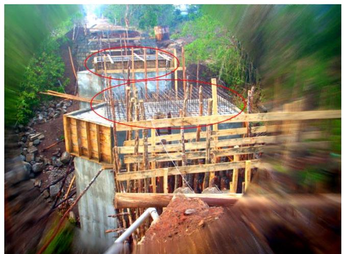
**Figure 66 :** Mise en œuvre de chevêtres
