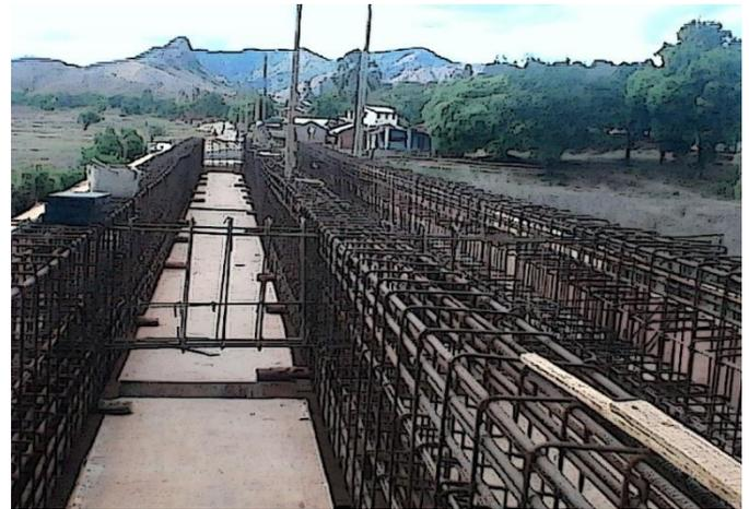
**Figure 70 :** Armature poutres et entretoises
