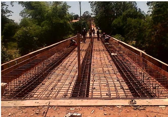
**Figure 71 :** Armatures des éléments du tablier mises en place
