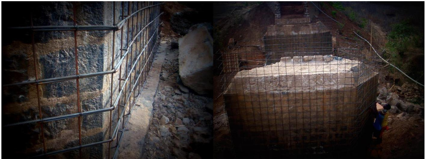
**Figure 64 :** Mise en place des armatures du sarcophage autour de la maçonnerie
