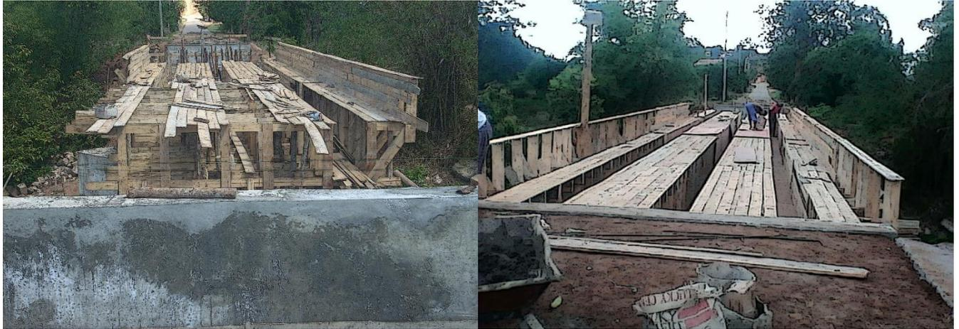
**Figure 68 :** Montage du coffrage des éléments du tablier
