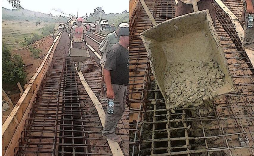
**Figure 73 :** Coulage du béton pour les éléments du tablier
