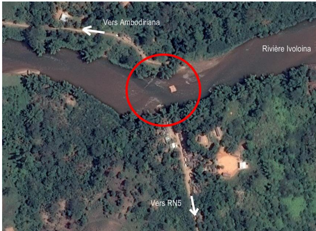
Figure 3: Vue aérienne du site (source : Google Earth 2016, échelle : 1/5000)
