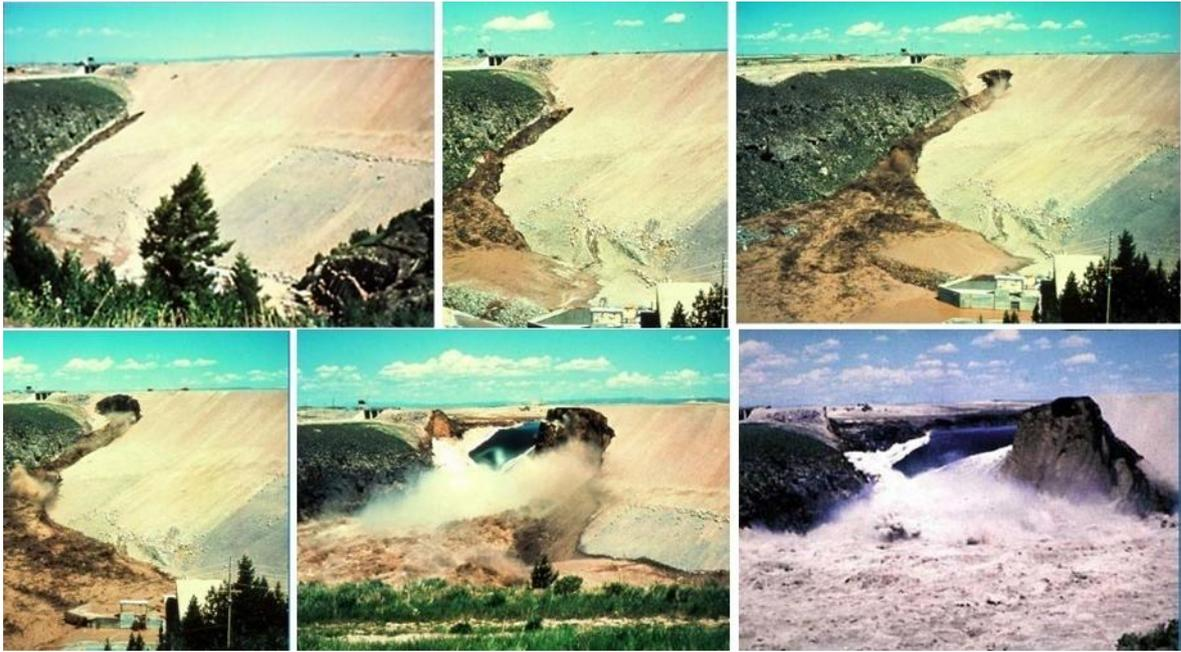
**Figure 9. 1.** Phases successives de la rupture du barrage Teton
