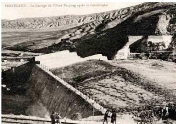
**Figure 13. 1.** Barrage de Fergoug, première rupture en 1881
