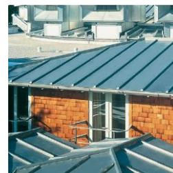
Figure 58 : Couverture en zinc à tasseaux
