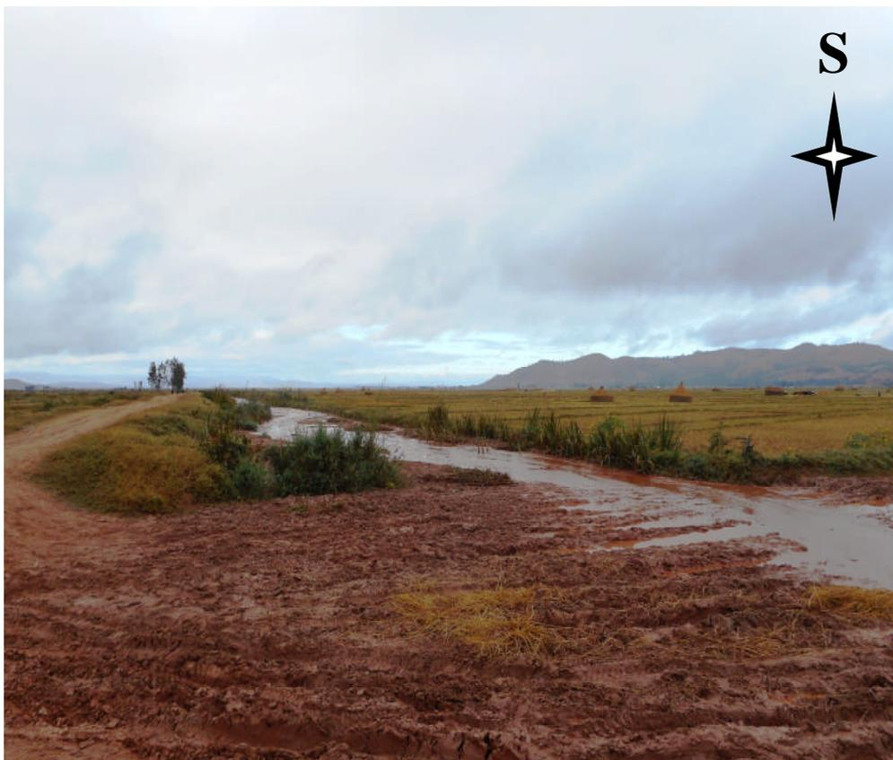
*Figure 42: Canal d'irrigation bouché par l'ensablement sur la plaine d'Amboavory*
