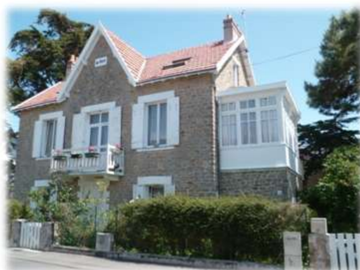
Illustration 22 : Exemple de maison dans le centre ville de Pornichet
