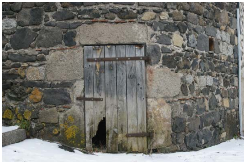
Figure 7. Encadrement de porte en trachyte. La Font de l'Arbre.
