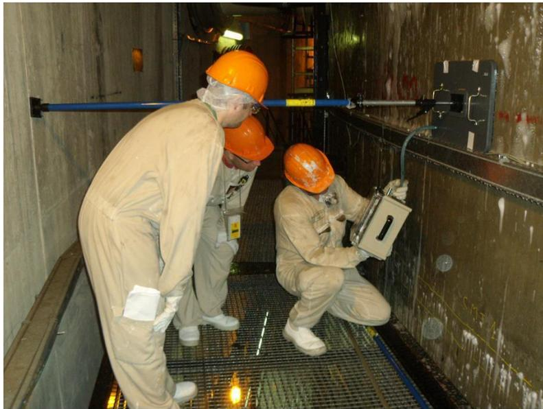
Fig. 1.8 : Boîte collectrice de fuite dans l'EEE et aspersion de l'extrados [83]
