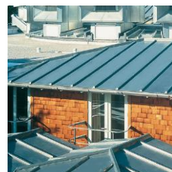
Figure 58 : Couverture en zinc à tasseaux
