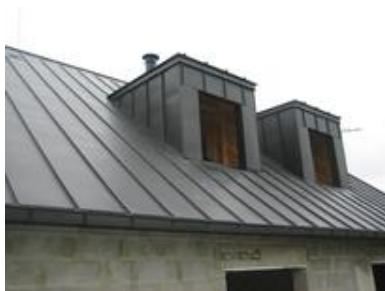
Figure 15 : Toiture en zinc
