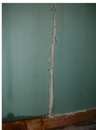
Figure 2.8 : L'isolant entre les plaques de BA-13 n'a pas été posé correctement (risque de déperditions élevées)
