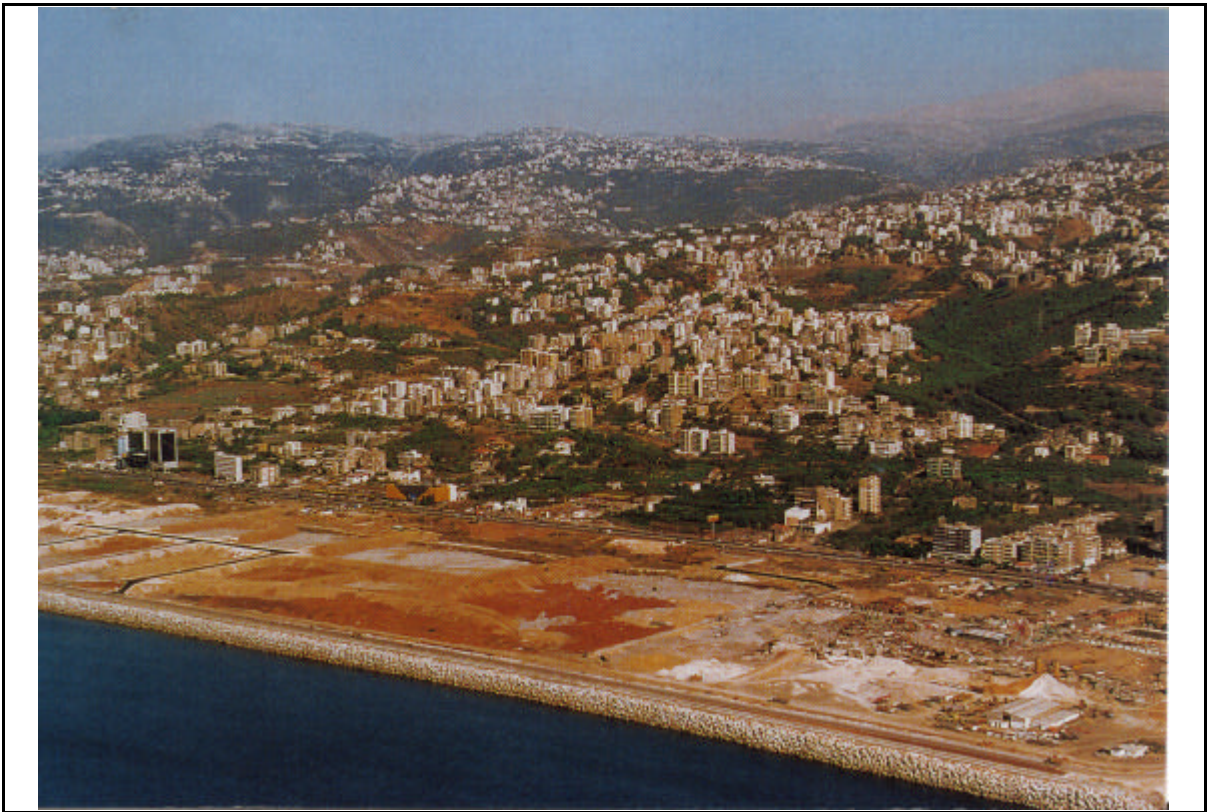
Figure n°11-3 : Vue du remblai Joseph Khoury en cours de réalisation
