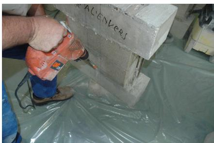
Figure 5.11 — Perçage des trous d'ancrage
