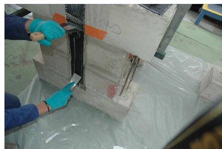
Figure 5.12 — Mise en place du TFC
