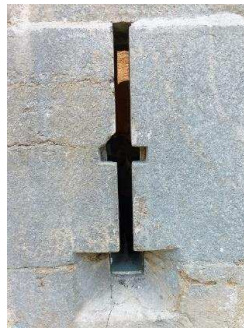
Figure 50 L'archère de la maison forte Vertrieu
