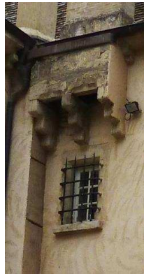
Figure 48 La bretèche du château Montchalin
