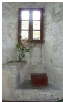
Figure 42 coussiège simple, maison forte Mollard-Rond
