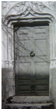
Figure 18 La porte du château Serrières
