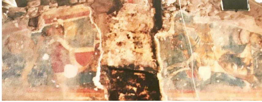
Figure 29 La scène de l'affrontement (détail), maison forte des Loives (Montfalcon) photo par T.LE DESCHAULT DE MONREDON, Le décor peint de la maison médiévale .
