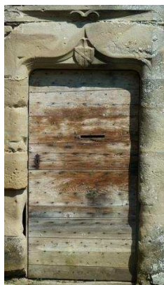
Figure 13 La porte de la maison forte Peythieu
