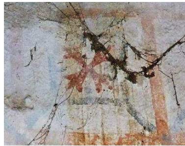
Figure 69 Détail des faux-appareils, maison forte des Loives
