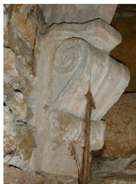
Figure 73 La tombée de voûte en mouluration, maison forte Montplaisant
