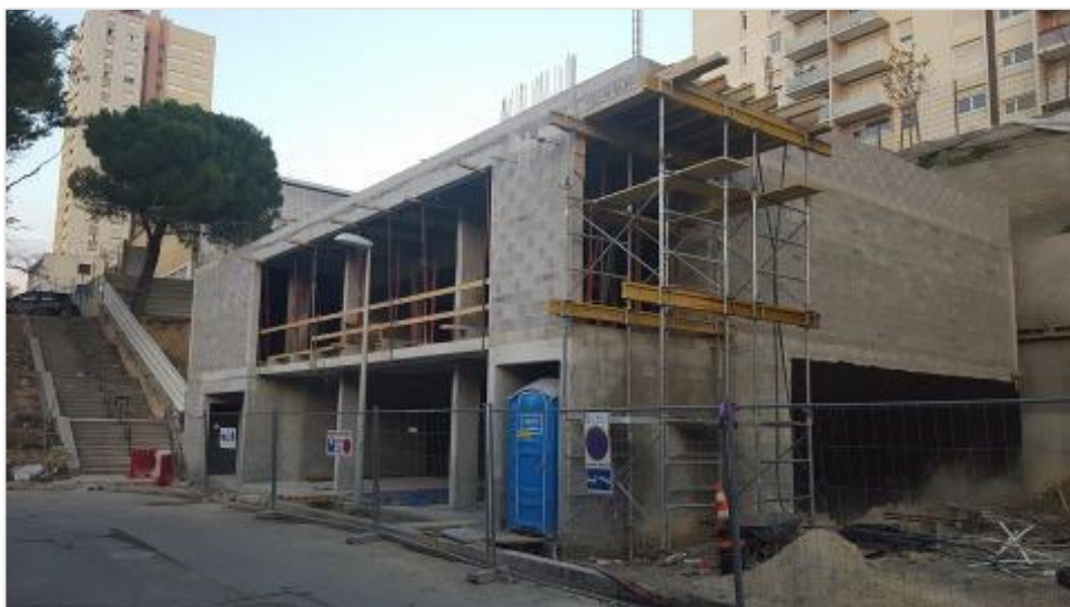
Photographie 16 : Chantier de la mosquée (2016)
