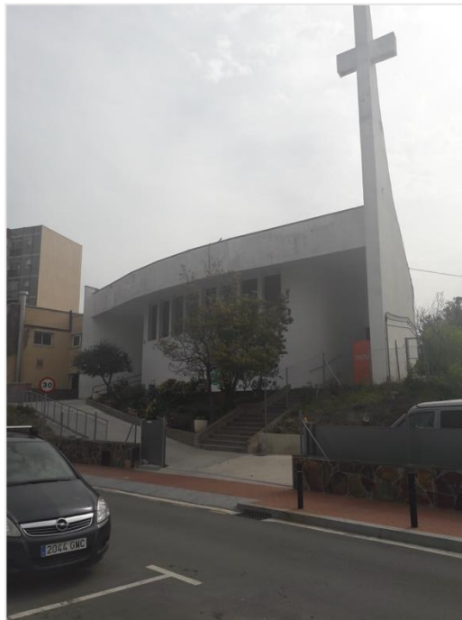
Photographie 13 : Église attenante au centre Cruïlla (2017)
