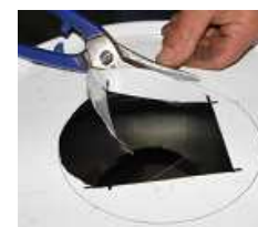
49. 50. Découpe d'un cercle avec une cisaille universelle sur le couvercle et sur le bidon.
