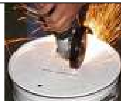
42. Fin de la soudure du coude du tuyau
