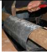
34. Martelage des points de soudure.
