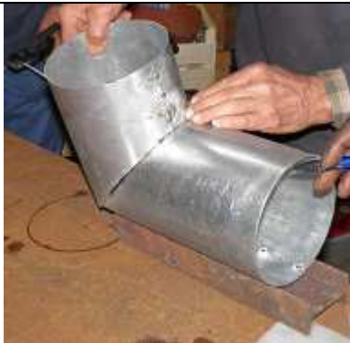
41. Soudure du coude du tuyau.
