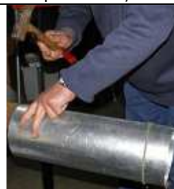
31. Fin du roulage du tuyau.
